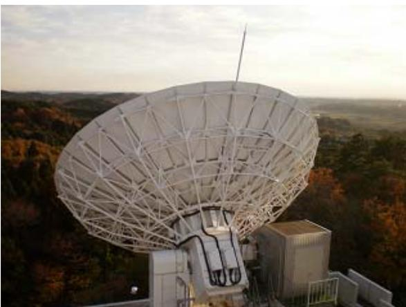
直径13mのアンテナ（MTSAT-1R用）。MTSAT-2用のアンテナとともに2基が送受信局舎屋上に設置。
