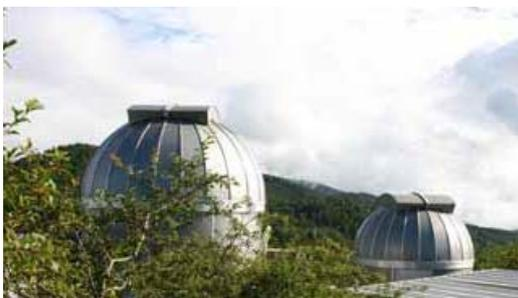
近年、増加する宇宙デブリの問題は国際的にも注目されており、正確な宇宙環境の把握が重要になっています。JAXA「入笠山光学観測施設」は、静止軌道付近のデブリを観測するために設置されたもので、光学望遠鏡による観測、並びに独自の画像データ処理による数十cm級の小さいデブリを検出する画像懐石手法の研究開発を行っています。
